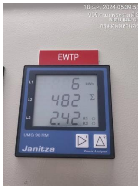
รูปที่ 2-34 มิเตอร์ระบบบำบัดน้ำเสีย
