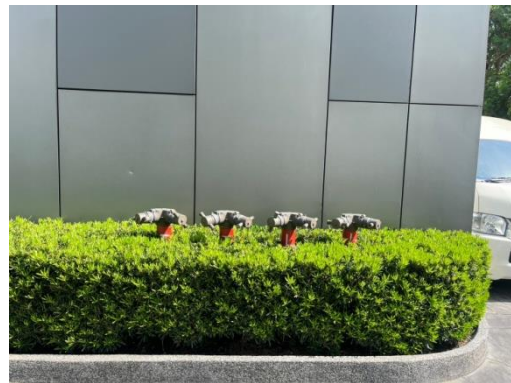
รูปที่ 2-24 หัวจ่ายน้ำน้ำดับเพลิง
