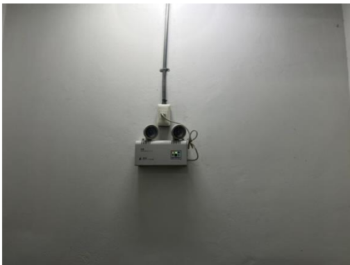
รูปที่ 2-25 เครื่องสำรองไฟ
